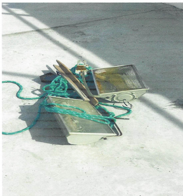
Foto 02 – REMOÇÃO DE LUMINÁRIS, DE FORMA MANUAL, SEM REAPROVEITAMENTO. AF_12/2017
