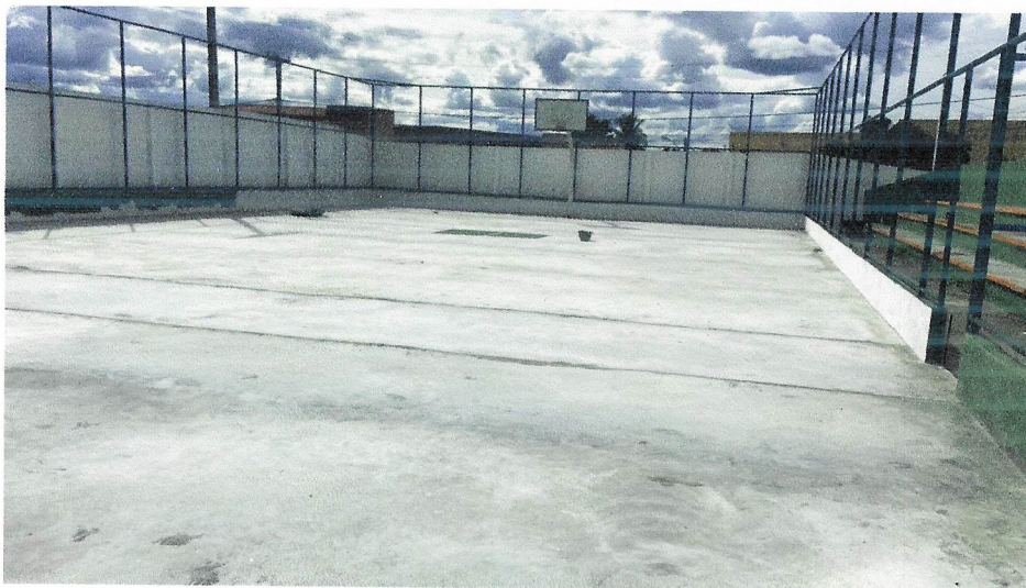
Foto 10 – ACABAMENTO POLIDO PARA PISO DE CONCRETO ARMADO OU LAJE SOBRE SOLO DE ALTA RESISTÊNCIA. AF_09/2021
