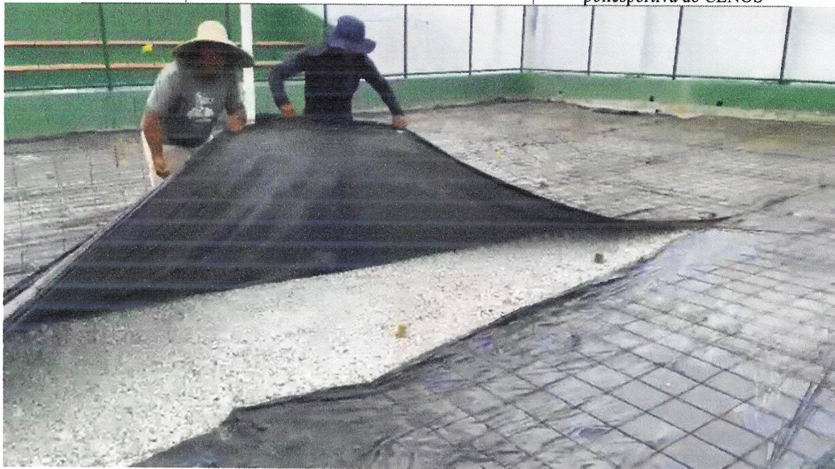
Foto 07- Lastro de brita graduada apiloada e=10cm
