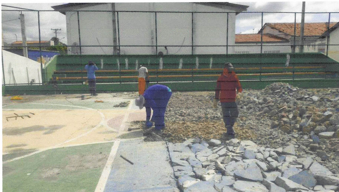
Foto 01 - Demolição de concreto com martelete e compressor
