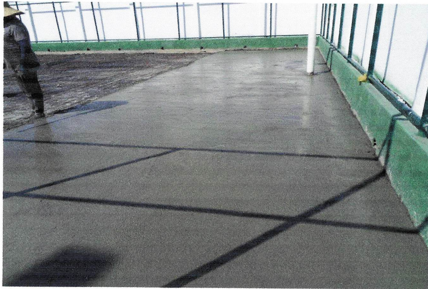
Foto 09 – PISO EM CONCRETO 20 MPA PREPARO MECÂNICO, ESPESSURA 7CM. AF_09/2020
