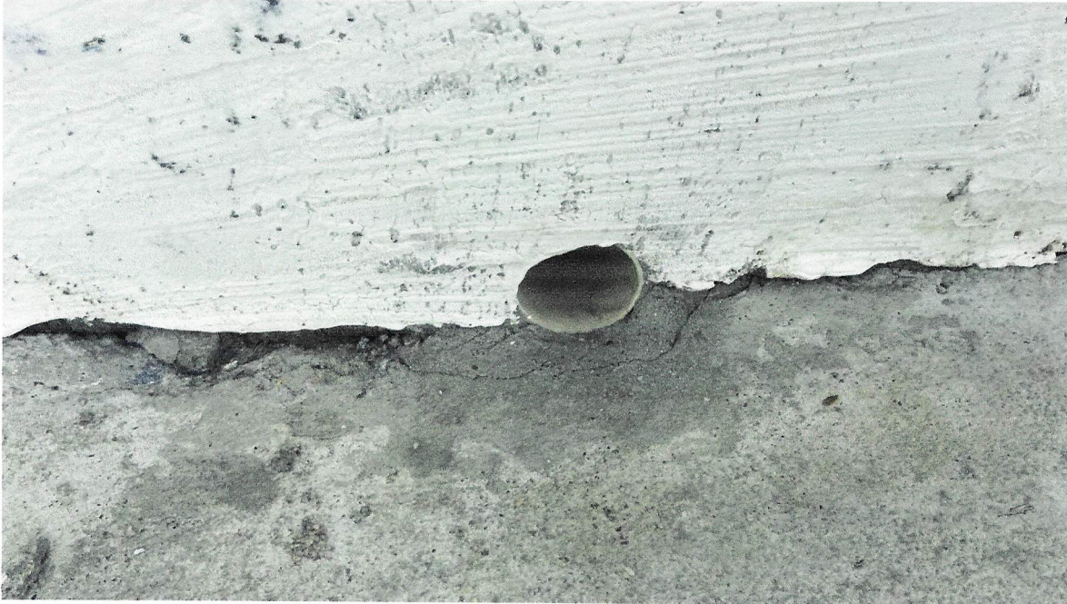
Foto 11 – A TUBO PVC, SÉRIE R, ÁGUA PLUVIAL, DN 75 MM, FORNECIDO E INSTALADO EM RAMAL DE ENCAMINHAMENTO. AF_06/2022
